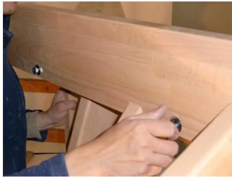
Handlauf auf die Stäbe setzen
