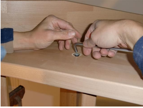
Verbindung Freiwange-Stufe
