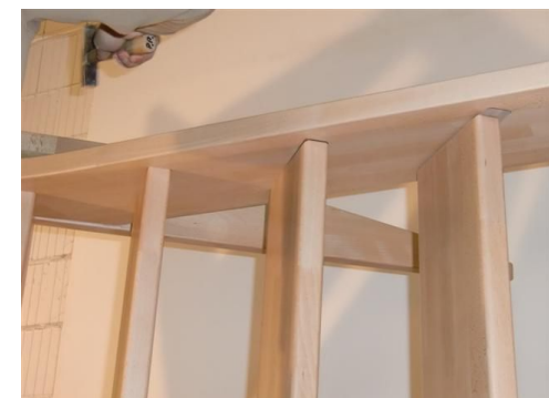
Freiwange auf Stufen setzen
