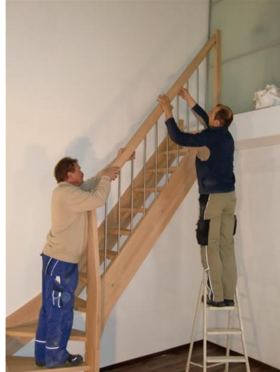
Handlauf auf die Stäbe setzen
