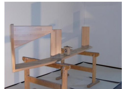
Freiwange auf Stufen setzen
