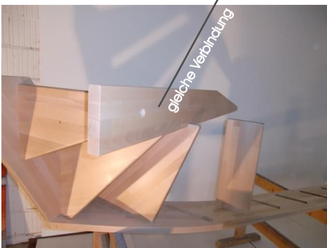
Pfosten-Stufenverbindung
