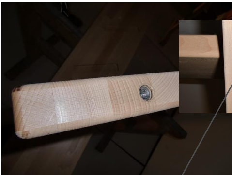
Stufen-Wangen Verbindung
