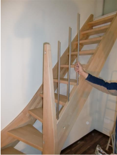
Verbindung T3, Pfosten/Handlauf
